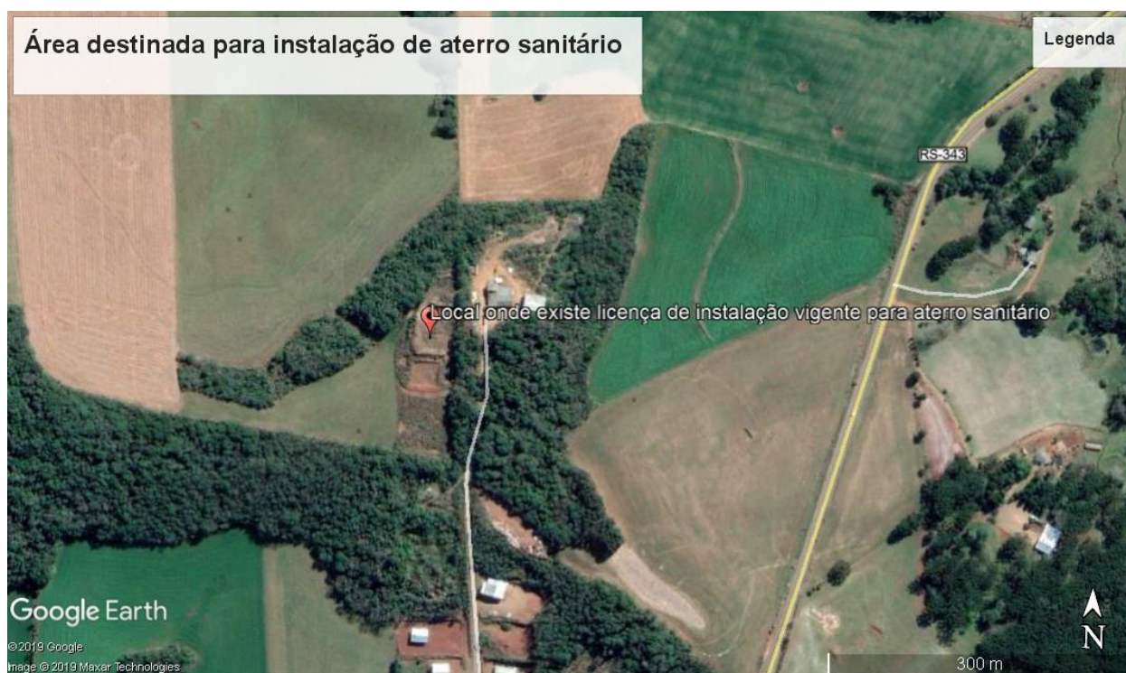
Figura 51. Área destinada para instalação de aterro sanitário.
