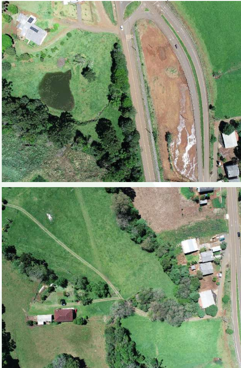
Figura 35: Imagens de drone do Trecho/Segmento 02 – locais consolidados em APP (obras e arroio tubulado)
