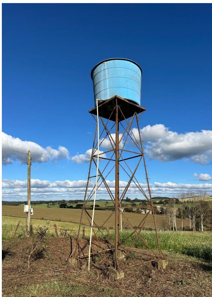
Figura 2 - Reservatório de água existente de 5.000 litros sobre torre metálica de 5 metros. Deverá ser desativada.
